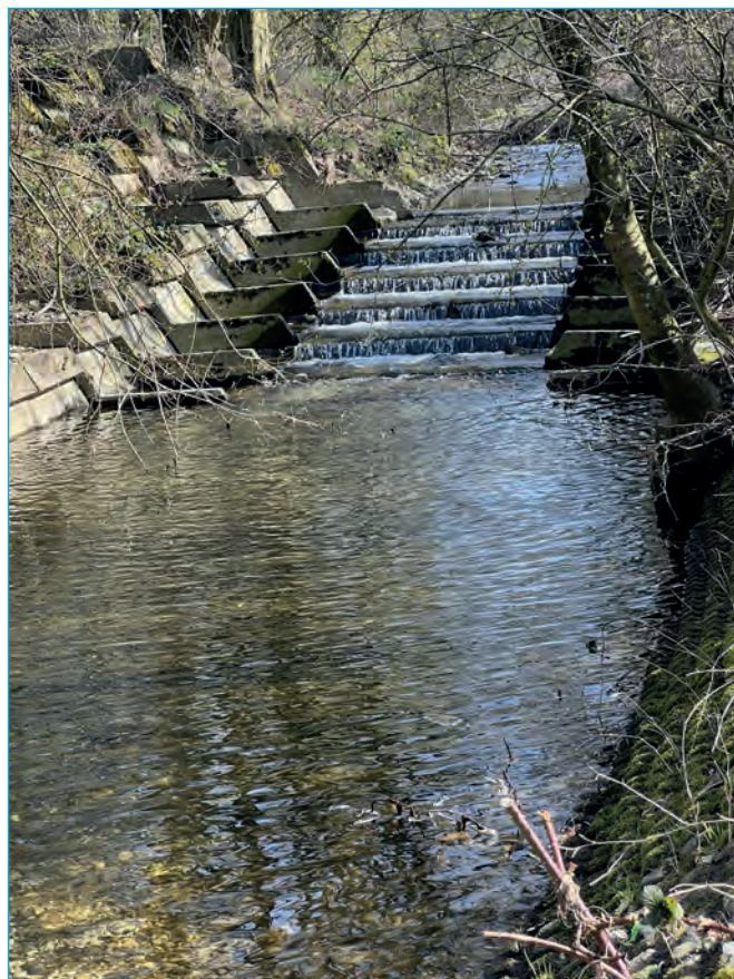
Abb. 11: Gestaltung des neuen Beke-Laufs (links = gleichförmiges Profil; rechts = Sohlgleite)
