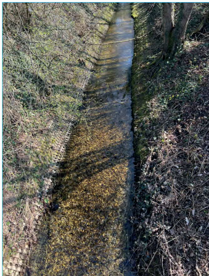
Abb. 11: Gestaltung des neuen Beke-Laufs (links = gleichförmiges Profil; rechts = Sohlgleite)
