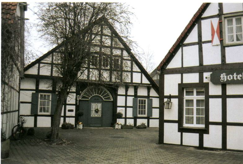
Restaurierte Fachwerkhäuser im Ortskern
