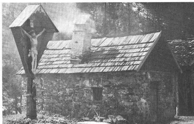
Bild 16 (März 1964) Waschküche als Nebengebäude
