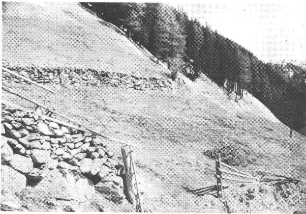
Bild 18 (April 1964) Feldsteinmauern am Hang bei Maik Schutz gegen Murgang
