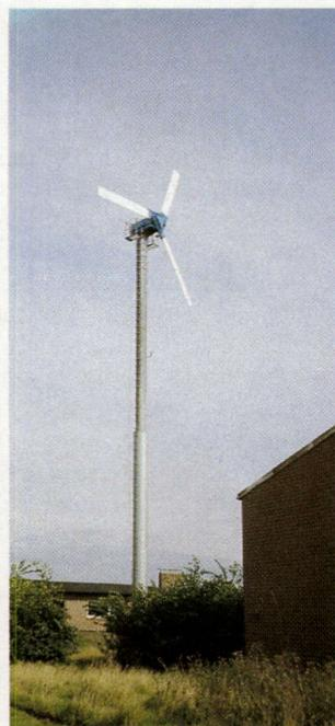
**Bild 4:** 35 kW-Lagerwey-Windgenerator in Nottuln. Nabenhöhe 24 m
