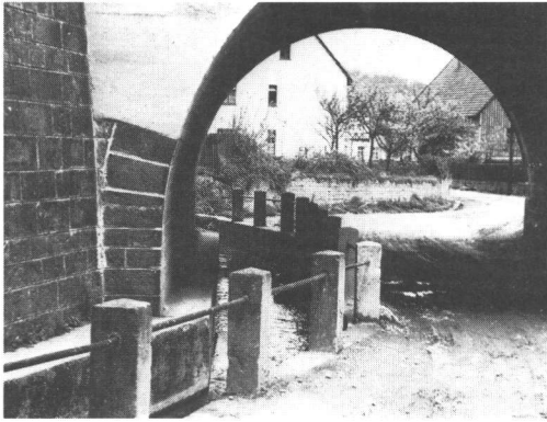
Bild 24: Bahnunterführung um 1950 mit offenem Bachlauf
