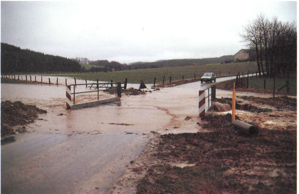
Bild 4: Unterspülung und Auskolkung von Brücken (Bilder 1-4: H. K. BARTH, Dezember 1988)
