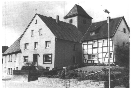
Bild 8: Verputzter Ersatzbau 1986 (vgl. Bild 7. Kahlschlag von Hausbaum und Sträuchern, Verlust von Trockenmauer und Lattenzaun)
