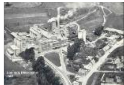
Abb. 3: Zementwerk Bomke und Bleckmann am Kollenbach, später Readymix, heute Cemex (Foto: Cemex AG)
