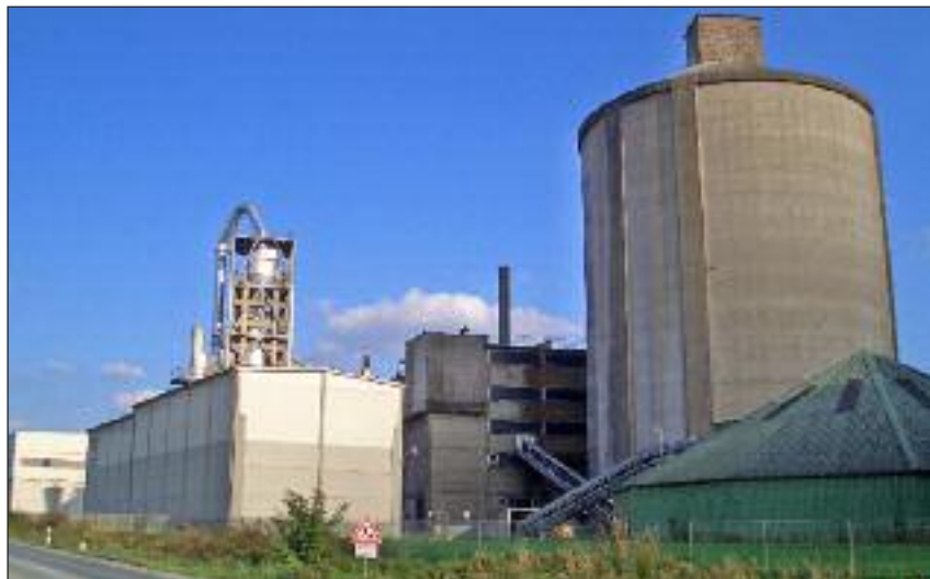
Abb. 6: Phoenix Zementwerk (Foto: Rudolf Grothues)
