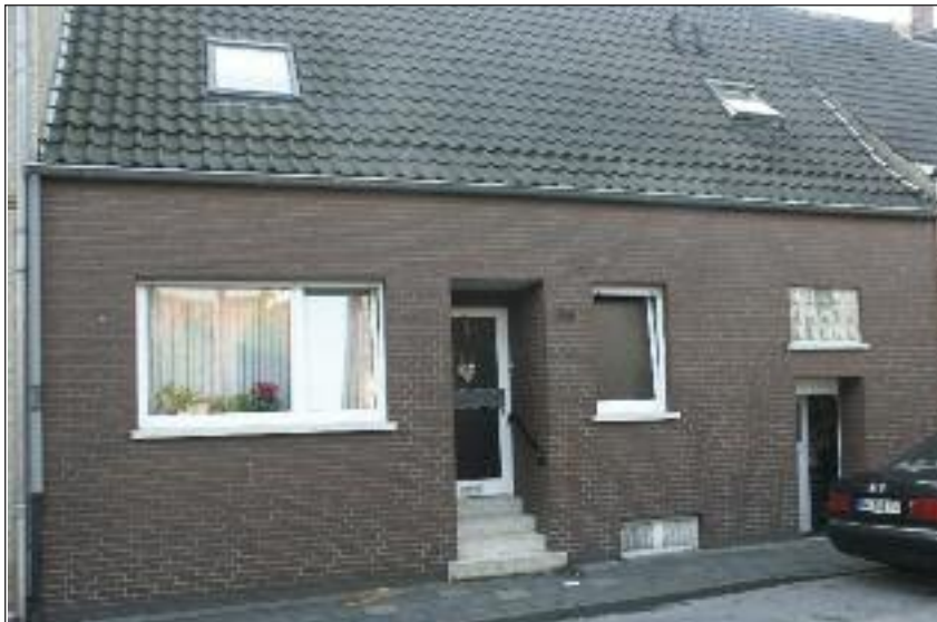
Abb. 4: Typus eines Arbeiterhauses. Beckum, Elmstraße (Foto: Stadtmuseum Beckum)
