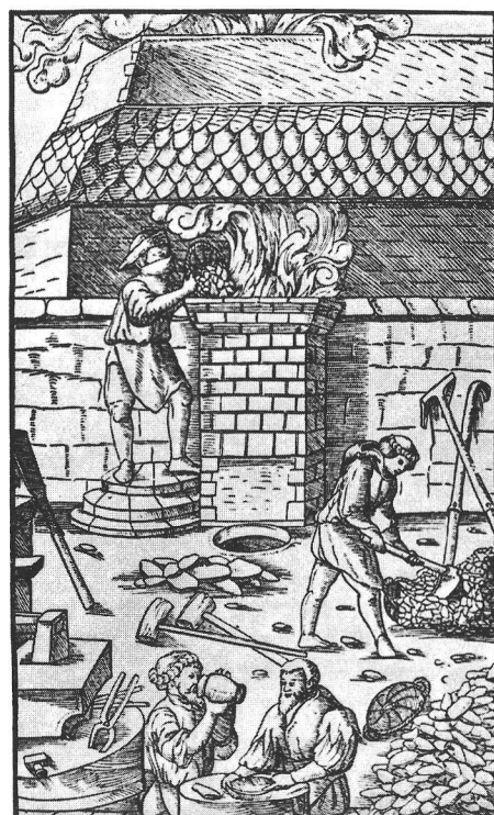
Bild 11: Schachtofen
