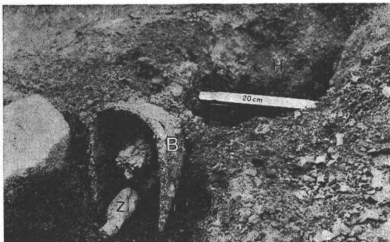
Bild 20 „Hülssiepen“, 2. Rennfeuer mit Herd (H), Abstich-Blechbügel (B) und Schlackenzapfen (Z)
