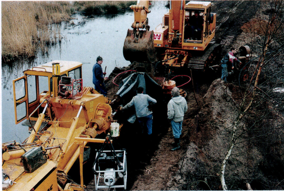
Abb. 4 : Folieneinzug in den Damm des Zwillbrocker Venns zur Abdichtung
