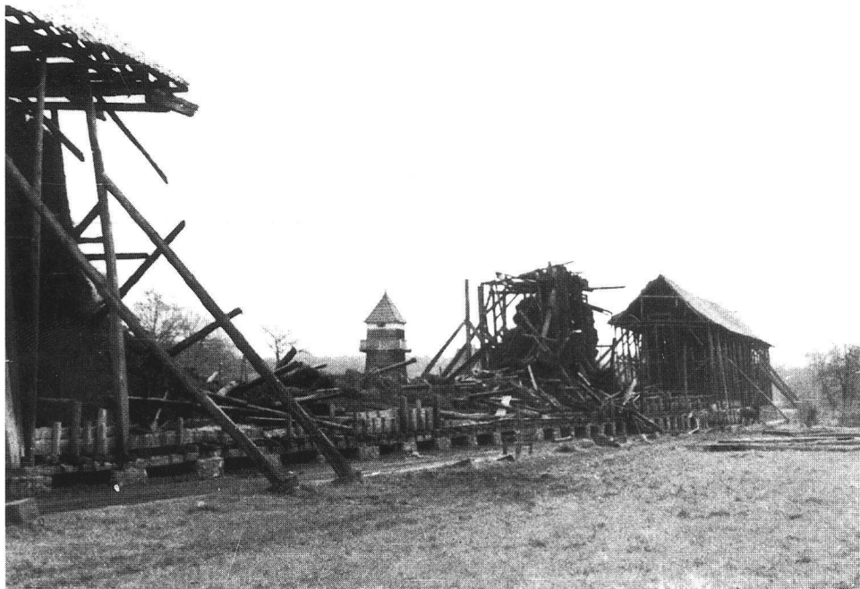
Bild 13: Das Gradierwerk nach dem Sturmschaden am 14.11.1940 (Foto: Stadtarchiv Rheine, Saline)
