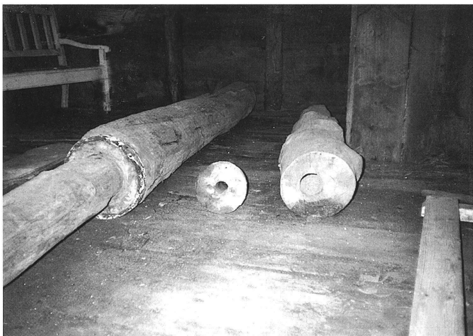
Bild 1: Verbindung zweier Holzrohre (Foto: A. Stockmann)
