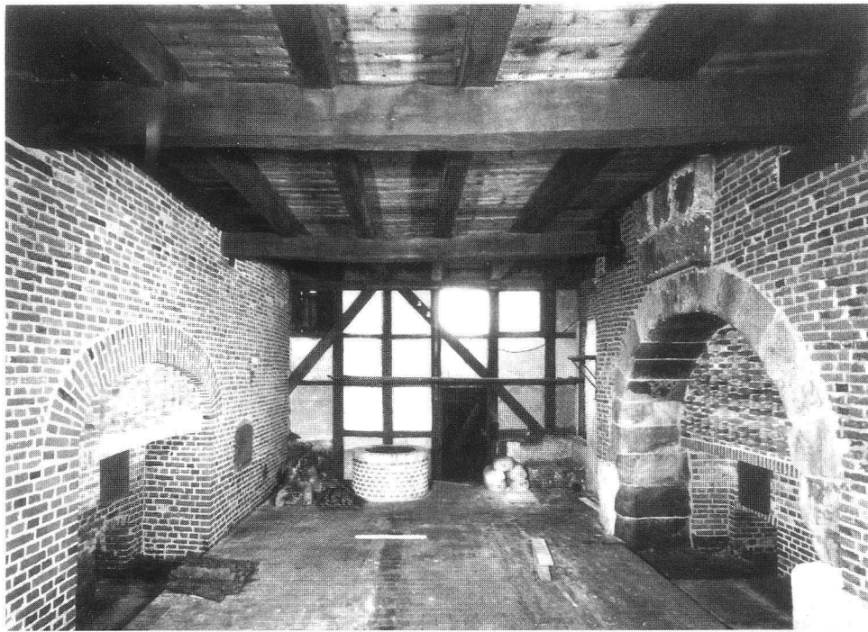
Bild 5a u. b: Siedehaus der Saline „Gottesgabe“ und gemeinsamer Feuerungsraum für zwei Pfannen
