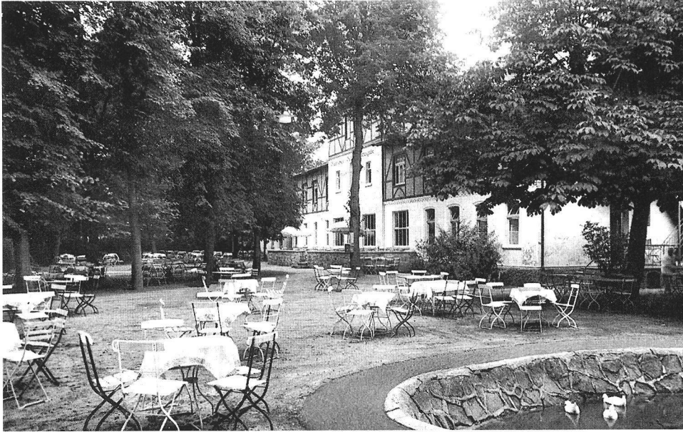
Bild 15: Badehaus und Restaurationsbetrieb nach der 1949 erfolgten Renovierung (Foto: Saline „Gottesgabe“)
