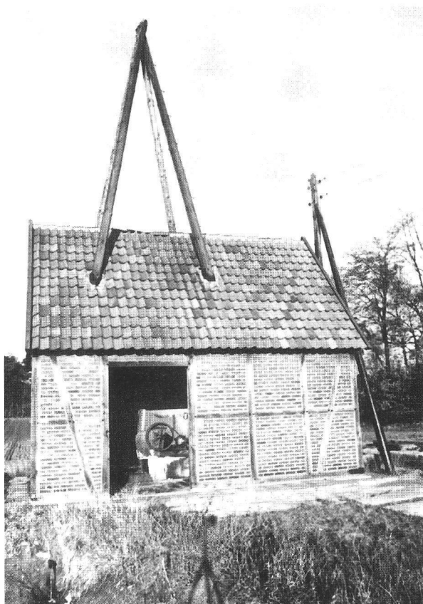
Bild 16: Pumpenhaus in Hummeldorf, errichtet 1959 (Foto: Stadtarchiv Rheine, Saline)
