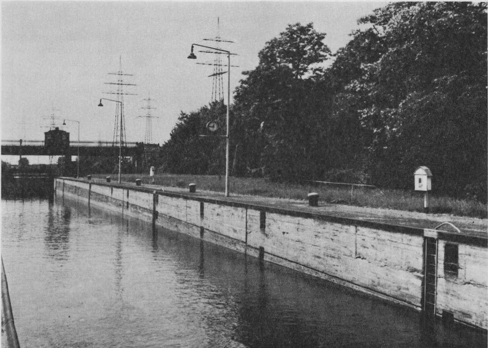
Foto 3: Ausgleich der Schiefstellung einer Schleuse durch keilmäßiges Aufbetonieren
